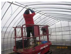
灌水パイプの取付け(3月26日)
