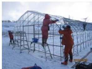
ビニールシートをかける作業(3月20日)
