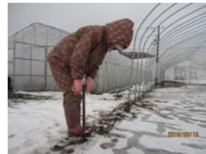
鉄骨を入れるための穿孔作業(3月15日)
