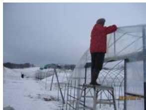
ビニールシートをかける作業(3月12日)
