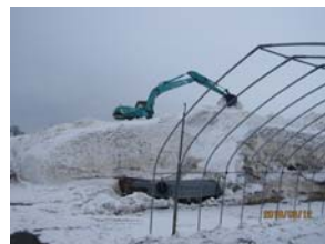
大型ユンボでの除雪作業(3月12日)
