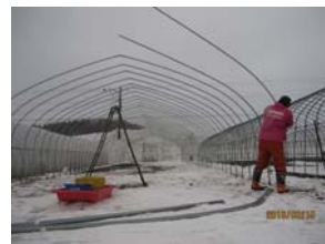
鉄骨の建て込み作業(3月15日)
