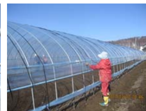
育苗ハウスの組み立て～ビニールテントを被せる作業(3月19日)
