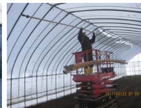
ハウスの天井部分に灌水パイプを設置しています(3月23日)
