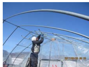
育苗ハウスの組み立て～ビニールテントを被せる作業(3月19日)
