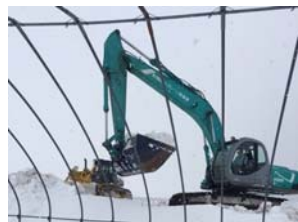
苗床の除雪作業(3月14日)
