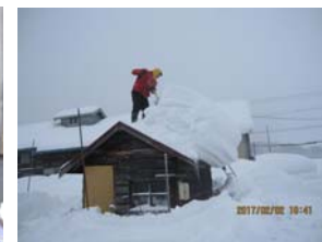
ポンプ小屋の屋根雪下ろし(2月2日)
