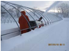
ハウス内の除雪作業(1月15日)
