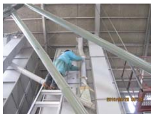
乾燥機の修理のようす(9月28日)
