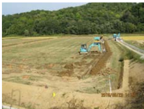
土木業者による暗渠工事(9月22日)
