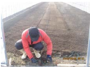
足場設置のため水糸を張る(4月4日)
