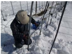
ハウスの組み立て(3月1日)
