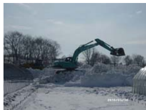
大型機械を使った除雪(3月10日)
