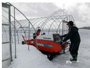
育苗ハウスを雪害から守るための除雪作業。毎年のことですが、結構体力がいる作業です。(2月20日早朝)
