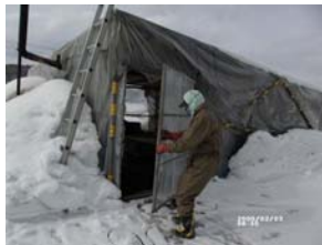
もみ穀の燻炭を作る作業小屋(2月20日)
