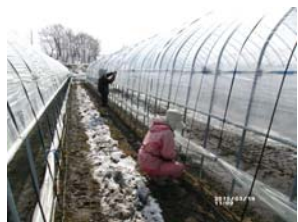
育苗ハウスの建て込み(3月19日)
