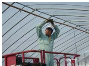
灌水パイプの取付作業(3月28日)
