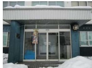
本社正面玄関のようす(12月31日)
