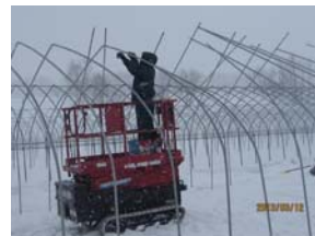
ハウスの組み立て作業(3月12日)
