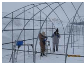
ハウスの組み立て作業(3月15日)
