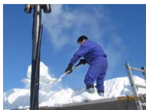
くん炭小屋の屋根雪下ろし(2月25日)
