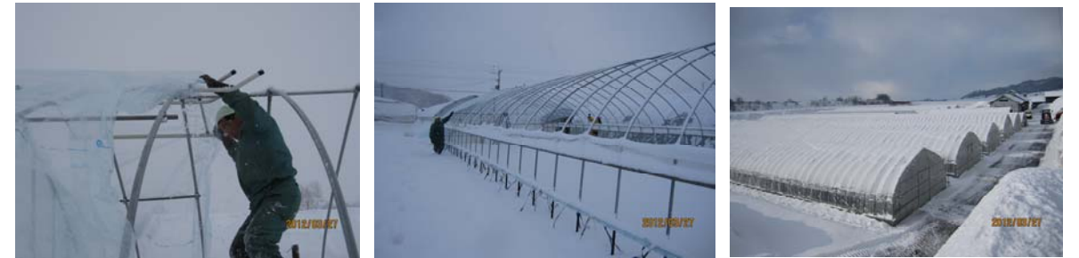
ハウスにビニールを被せる作業(3月27日)～商品名「ころすけ」という器具を使って2人1組で作業を行います。
