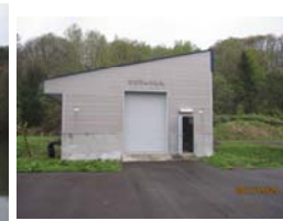
ダムの水を送水する為に作られた揚水機場
